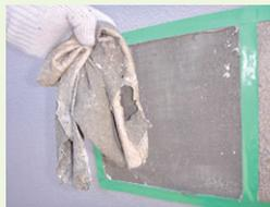
はく離した塗膜は湿潤シート状態で回収可能です。塗膜に含有する有害物質の飛散、拡散が低減できます。
