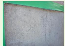
塗膜はく離後、再塗装する塗料に適する素地調整程度を検討します。残存した塗膜がある場合、除去方法を検討します。
