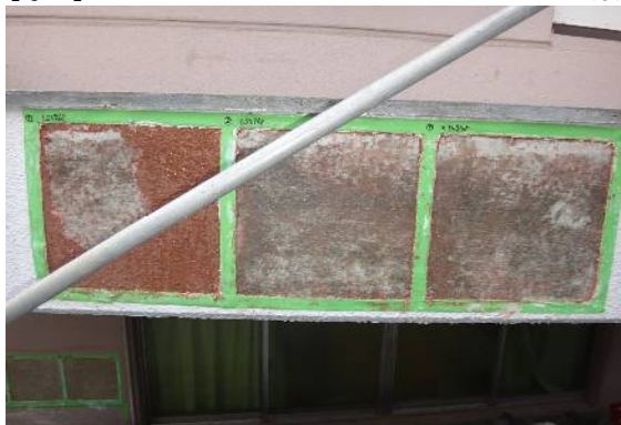
【試験箇所 No.2】塗膜はく離作業終了状態（2回目）
