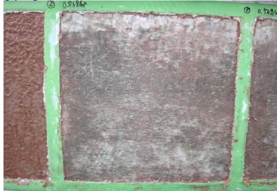
【試験箇所 No.3 ③】壁面（たれ壁）（塗付パターンC）
