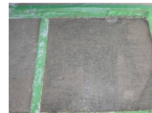
塗膜はく離除去作業完了状態
