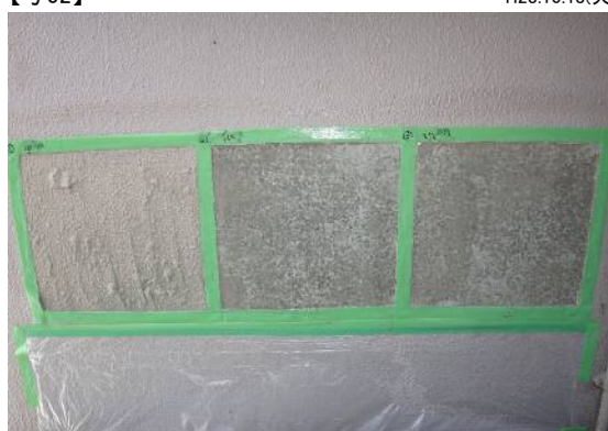
【試験箇所 No.1】塗膜はく離作業終了状態（1回目）
