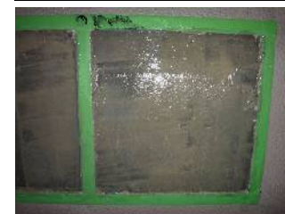
バイオハクリRE 塗付完了状態 (2回目) 塗付量: 0.5\text{kg}/\text{m}^2 ( \approx 45\text{g}/0.09\text{m}^2 )
