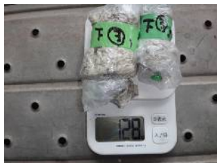
はく離回収した塗膜重量測定状態 128g/0.09m 2 ≒ 1,422g/m 2 (回収塗膜および養生マスキング含む)
