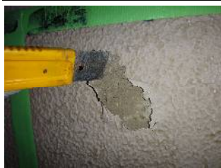
塗膜の軟化状態の確認 皮スキなどで塗膜の軟化状態を確認する。
