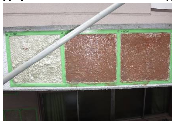
【試験箇所 No.3】塗膜はく離作業終了状態（1回目）
