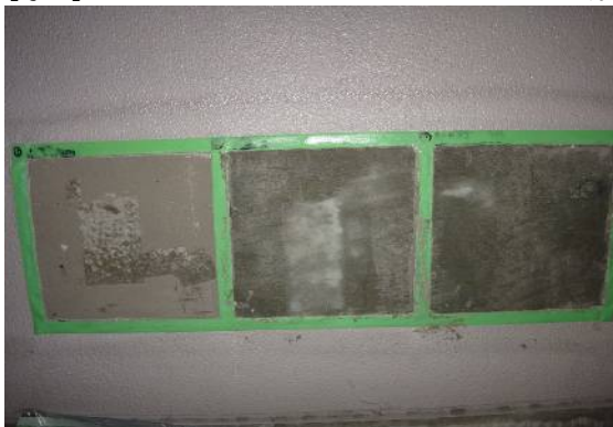
【試験箇所 No.1】塗膜はく離作業終了状態（2回目）
