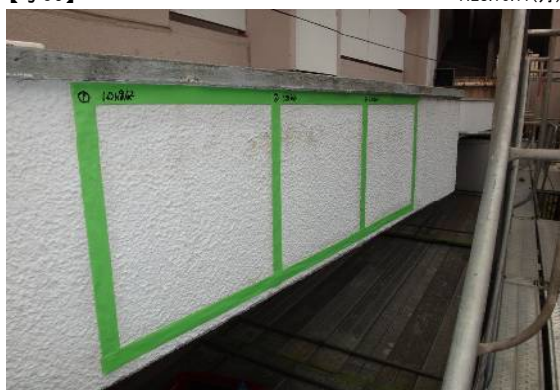
【試験箇所 No.3】1階 壁面（たれ壁）
