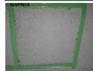
塗膜はく離作業(1回目)の状態 1回目の塗膜はく離作業後、最下層塗膜層が残存する状態
