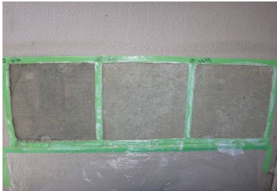
【試験箇所 No.2】塗膜はく離作業終了状態（2回目）
