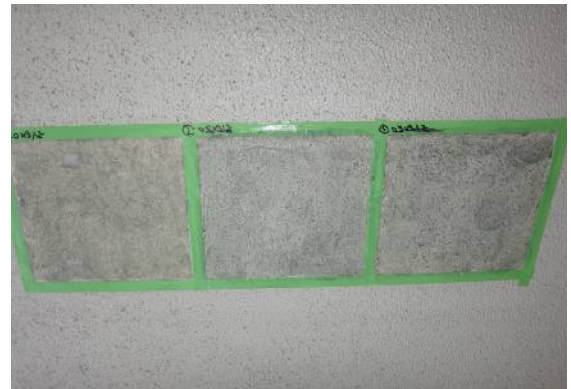
【試験箇所 No.2】塗膜はく離作業終了状態（1回目）
