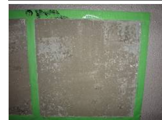
塗膜はく離作業(1回目)の状態 1回目の塗膜はく離作業後、最下層塗膜層が残存する状態
