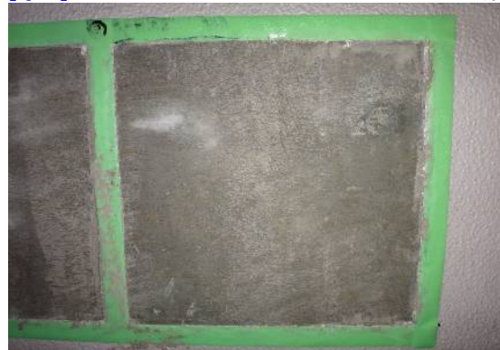
【試験箇所 No.1 ③】壁面（塗付パターンC）
