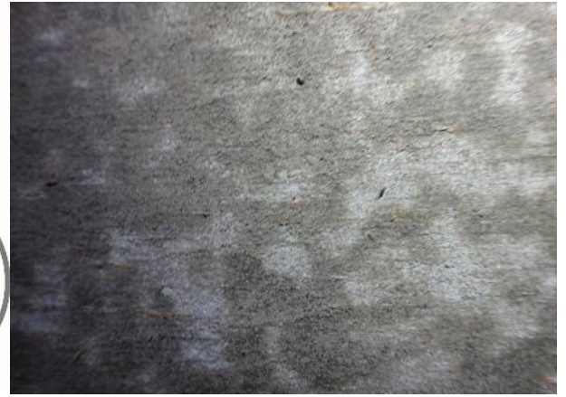
試験箇所 No.1 壁面 ③ 塗膜はく離作業完了状態 躯体下地面凹部に残存する塗膜の状態
