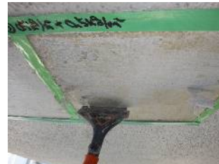
塗膜はく離作業 (2回目) 使用工具: 刃付スクレーパー
